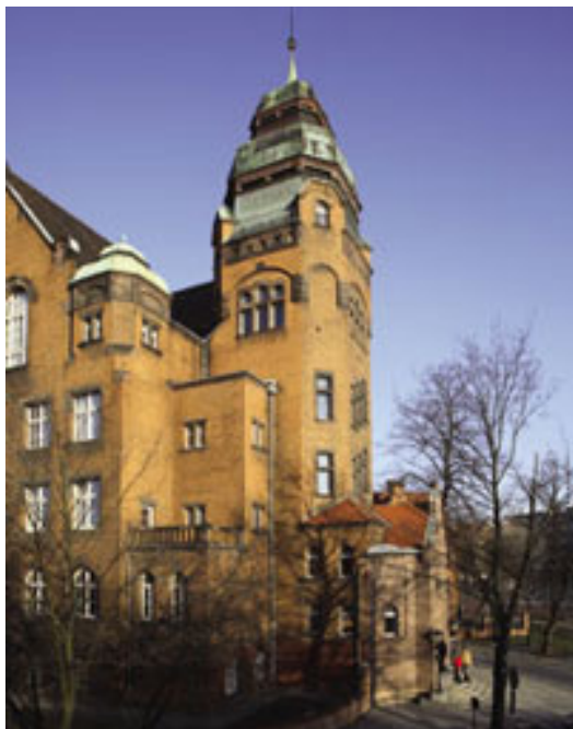
Rektorat i budynek administracji
